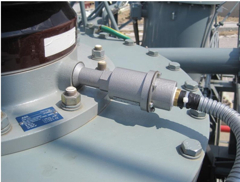
Рис.3 Устройство присоединения к измерительному выводу на вводе фирмы АВВ
